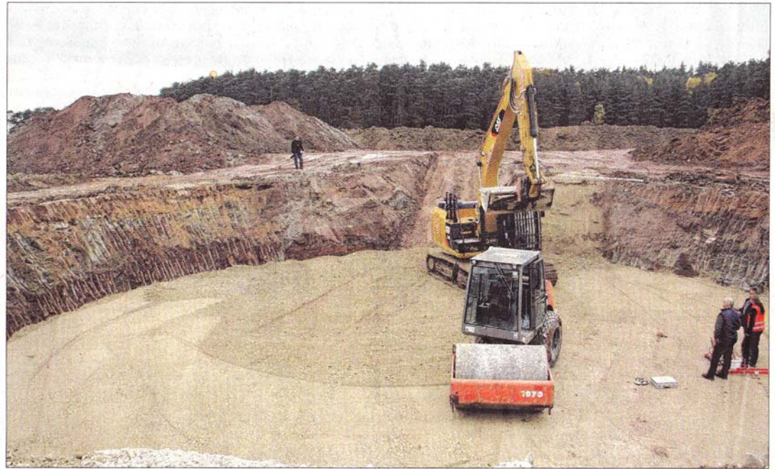
Im Bürgerwindpark Mausdorf-Pirkach entsteht ein drittes Windrad.
