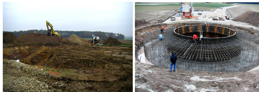
Erdarbeiten und Fundamentbau
