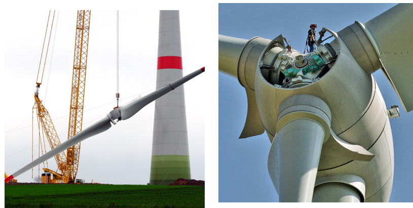
Generator und Rotormontage
